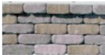
Mur d'assise de 8 po - Liaison courante
