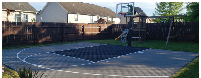
Primera cancha de baloncesto con Brock PaverBase
